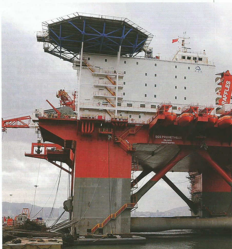
25 de noviembre de 2013. Dos plataformas grúa semisumergibles en aguas profundas, diseñadas y construidas por CIMC Raffles, se entregan en Yantai. Se pondrán en funcionamiento en Brasil. Cnsphoto
